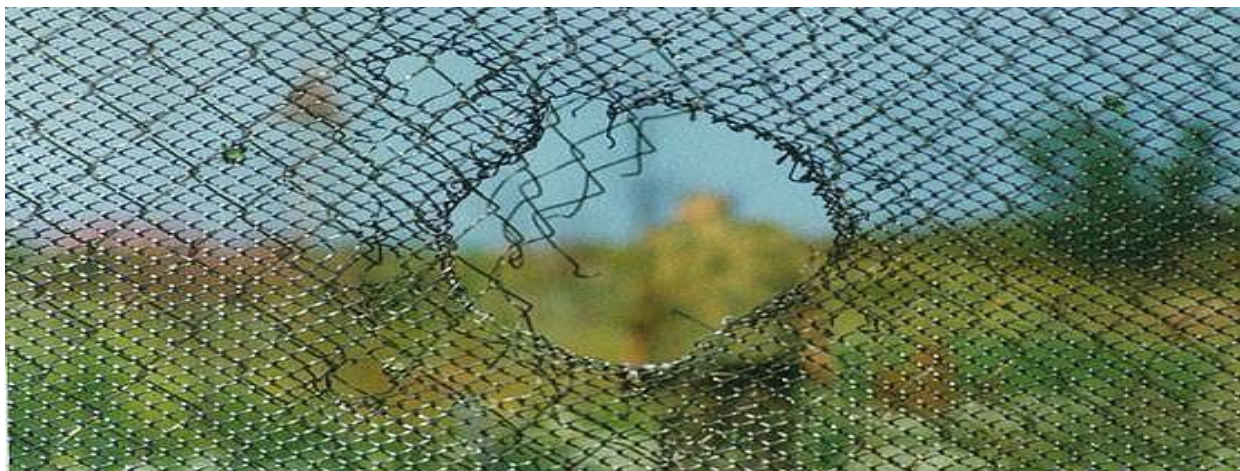
Рис.12 Применение сетки-рабицы для защиты от мини- и мкробПЛА
