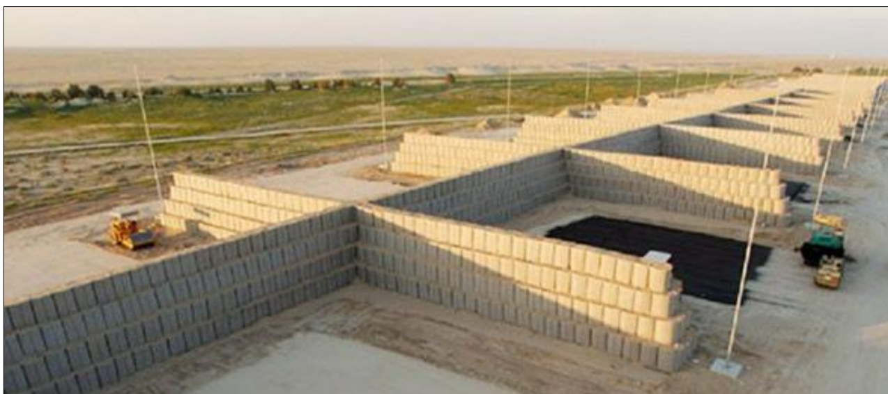
Рис.11 Вариант установки габионов насыпного типа
